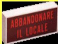
*Le concentrazioni di CO<sub>2</sub> necessarie per lo spegnimento non permettono la sopravvivenza delle persone, per cui l'installazione di questi impianti in locali con presenza di persone impone l'adozione di adeguate procedure di sfollamento.*
